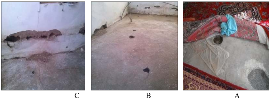
شکل شماره ۱۴- آثار هجوم جوندگان به خانه های اهالی روستای نجف آباد: A: کنده شدن کف خانه های مسکونی توسط موش ها. B و C: خالی از سکنه شدن خانه های مسکونی در اثر تخریب موش ها.
